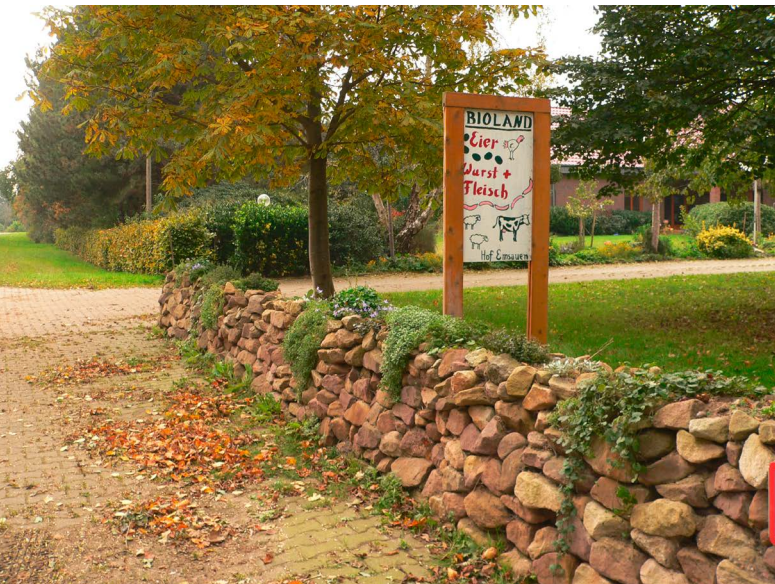
Eine Trockensteinmauer kann den Hof zur Straße hin abgrenzen und gleichzeitig Spalten und Ritzen für unzählige Kleintiere bieten, wenn sie ohne Mörtel aufgebaut wird. Foto: Birgit Petersen
